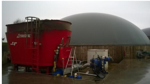
Bol mélangeur devant le 1 er digesteur ©Marion Delesalle/Agro-Transfert
