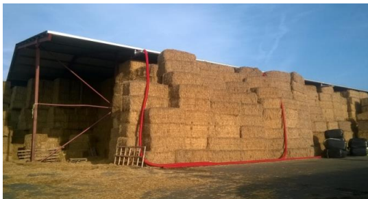
Hangar de paille de PCVF. ©Marion Delesalle/Agro-Transfert
