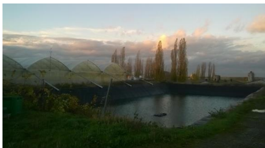
Serres et bassin de rétention d'eau pluviale. ©Marion Delesalle/Agro-Transfert
