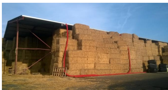
Hangar de paille de PCVF. © Marion Delesalle/Agro-Transfert
